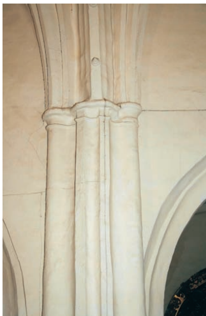
Foto 9. Iglesia de Santa María del Moral: impostas de las columnas.
