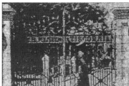
Puerta de entrada al Campamento de Tiscornia.
