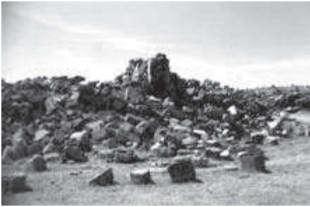
[036] Estado en que quedó la Iglesia de Argusino tras su demolición por parte de Iberduero (1967).
