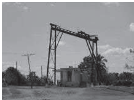
Grúa y estación de ferrocarril de Carrera Larga.
