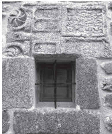
Aspecto actual del ventanuco de la antigua escuela de Escudro, coronado por una estela romana reaprovechada en el momento de la construcción del edificio.
