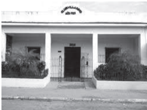
Fachada del Club Villarino.
