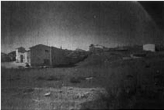
Zuzones. Vista parcial. Provincia de Burgos.
