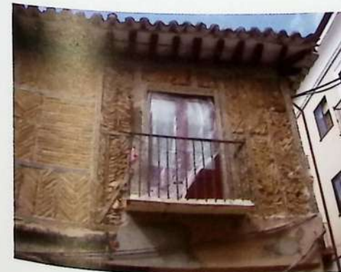
Foto 5. Pared de ladrillo.
