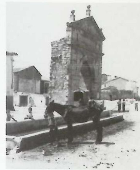
Foto 1. Piloñ para limpieza de bocoyes.
