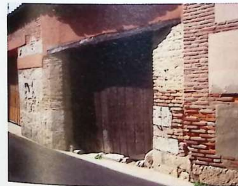
Foto 3. Rodapiés en portal.
