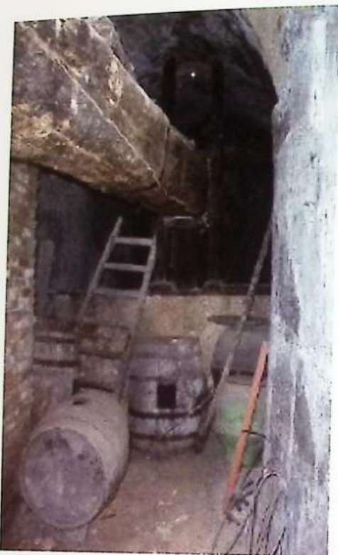
Foto 16. Bodega y viga.
