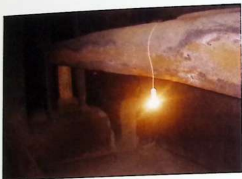
Foto 1. Viga y lagar.
