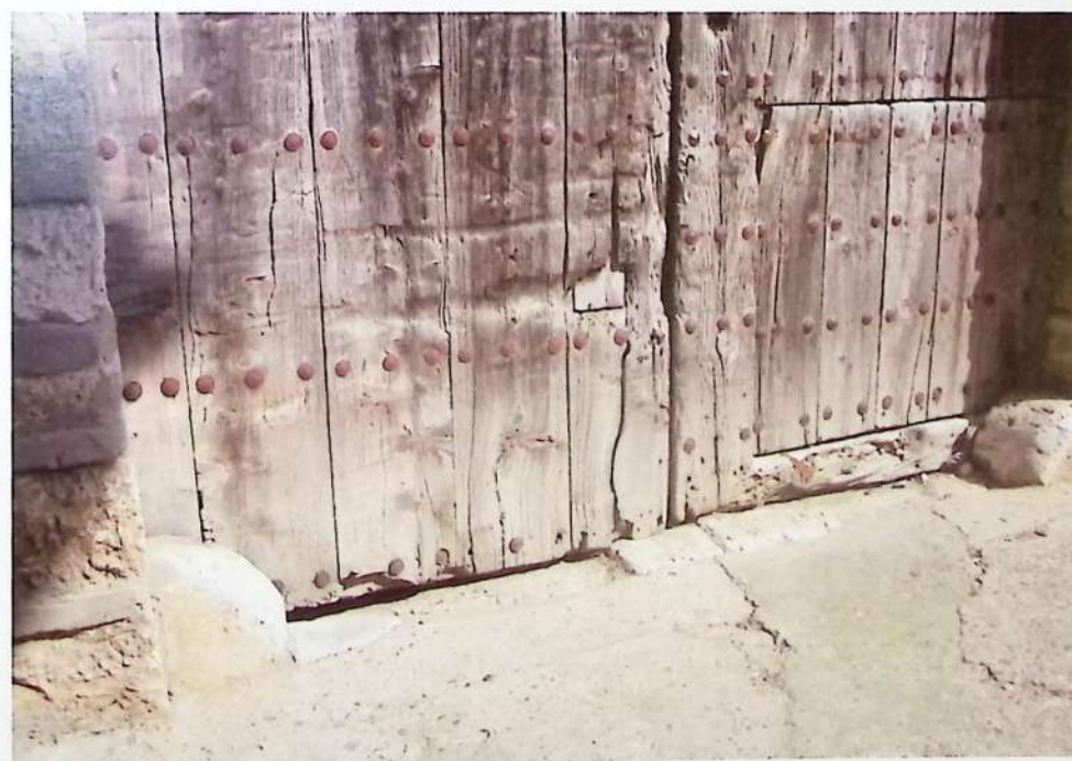
Foto 4. Rodapiés en portal.
