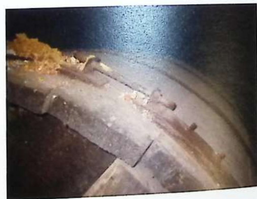
Foto 22. Tensado de flejes.
