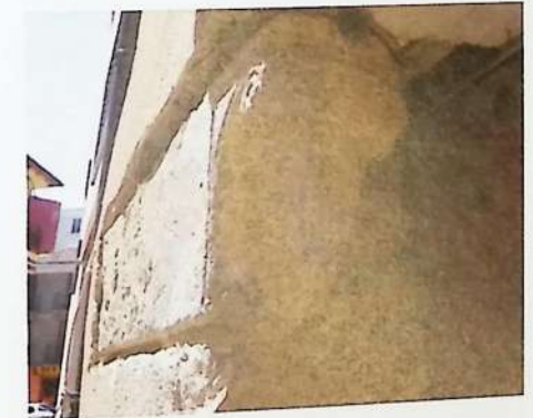
Foto 4. Imposta en puerta.
