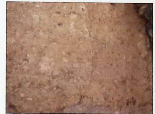
Foto 6. Edificaciones con tierra de bodega.
