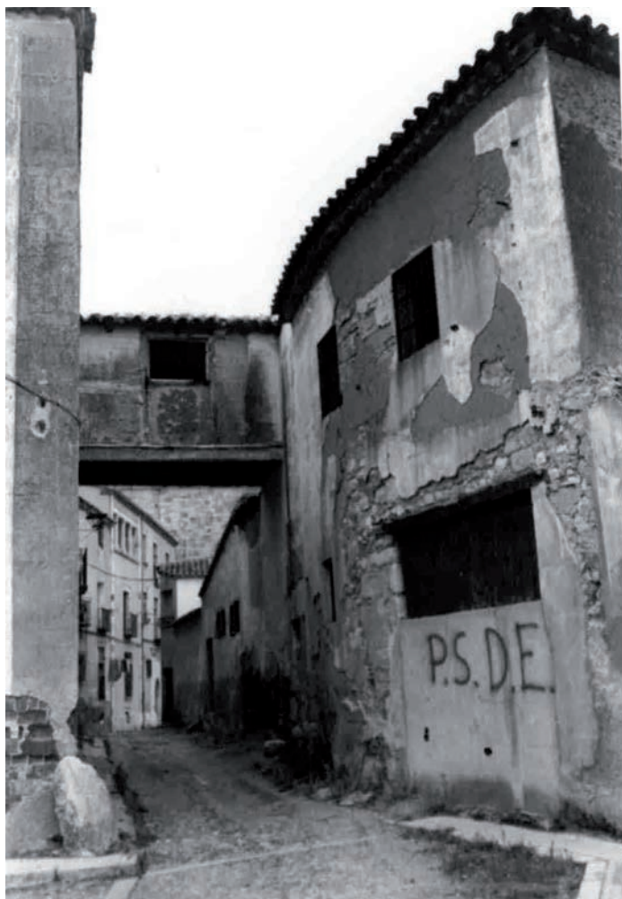
Fig. 16. Pasadizo elevado entre la Capilla de los Ciento y la Casita de Nazaret. 1978.
