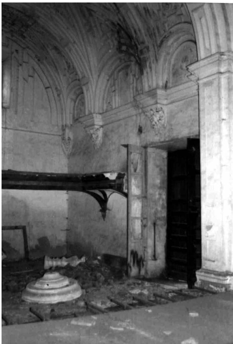
Fig. 19. Interior de la nave de la Capilla de los Ciento y entrada desde la plaza homónima. 1978.
