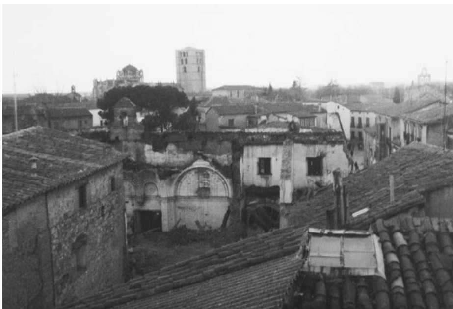
Fig. 15. Capilla de los Ciento. Derribo. Marzo de 1979.
