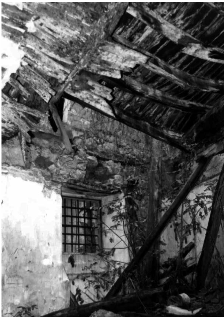
Fig. 12. Hospital de los Ciento. Estado de las dependencias interiores. 1978.
