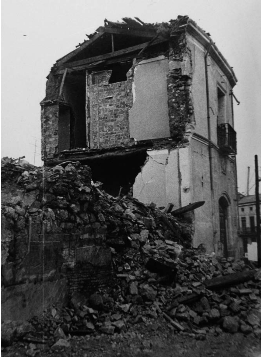
Fig. 20. Alzado del Palacio de los Valencia. Derribo. Abril de 1976.
