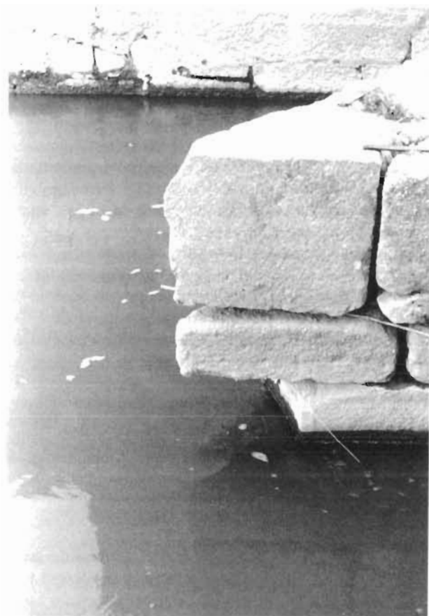
Foto nº 1 «Detalle del rompiente de una torre de las aceñas de Cabañales»
