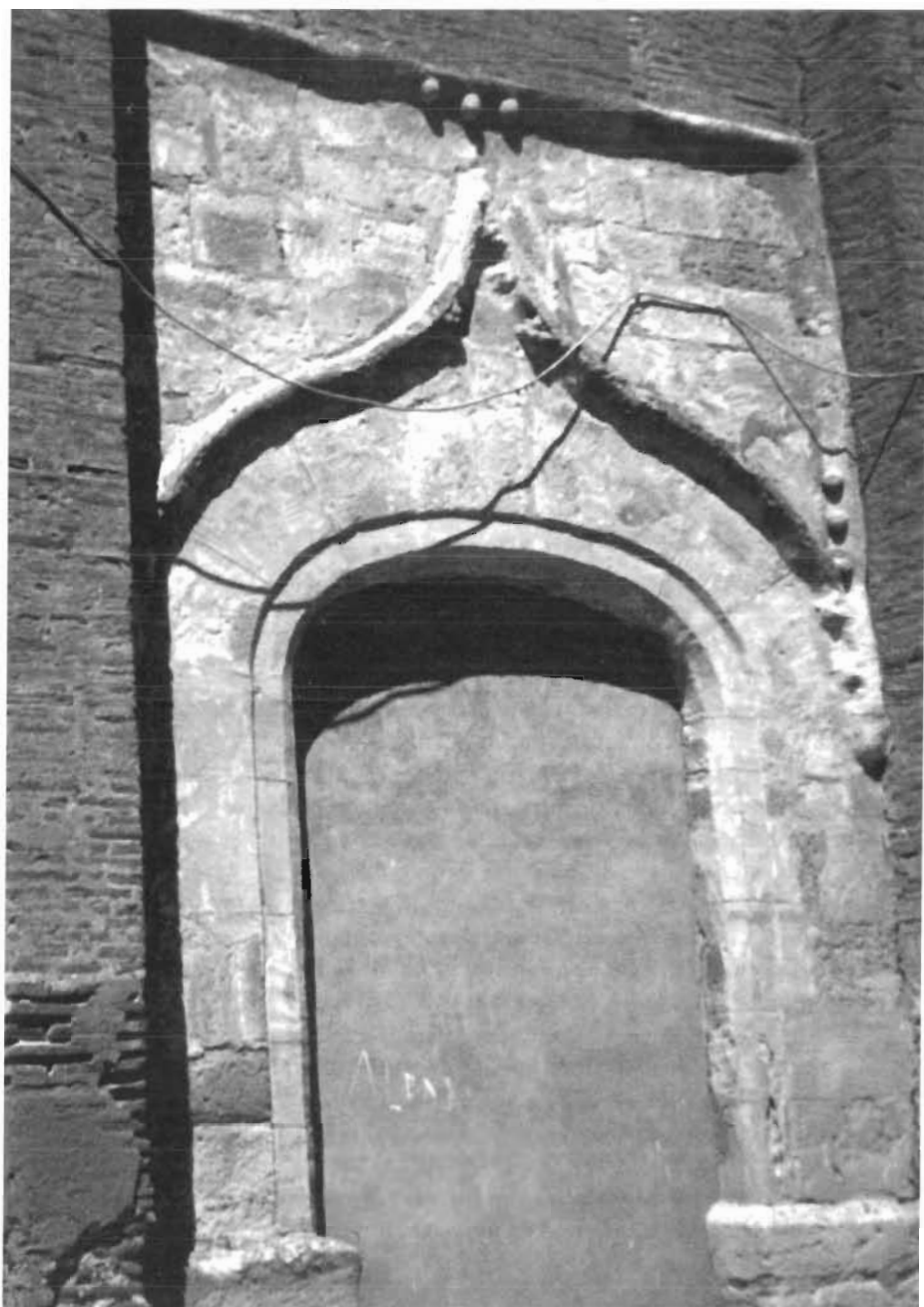
Portada principal de la Iglesia Primitiva trasladada al final de la nave central en la ampliación.
