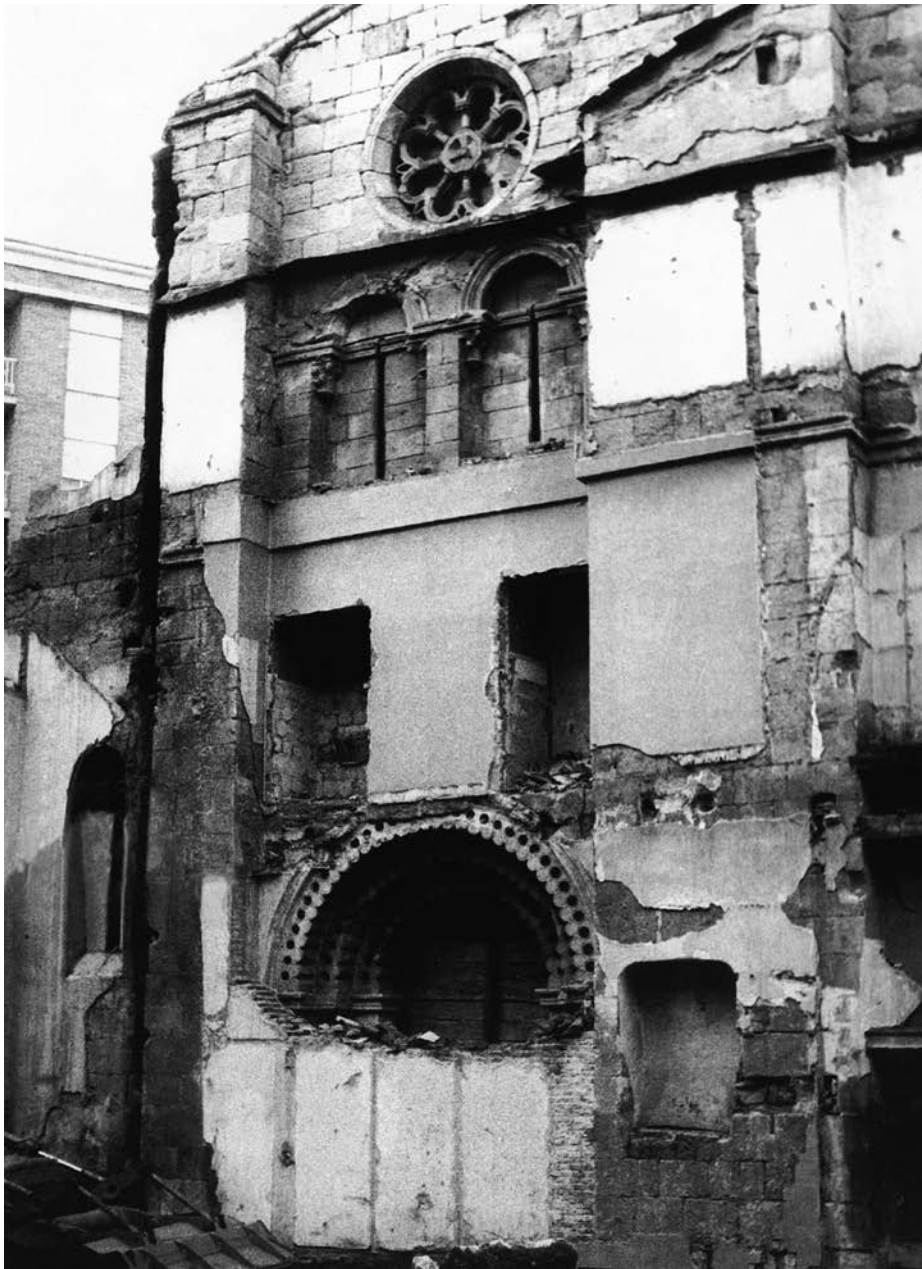
Fig. 13. Hastial de la Iglesia de Santiago del Burgo tras el derribo del edificio del Banco de Fomento, hacia 1976, Ángel-Luis Esteban Ramírez .
