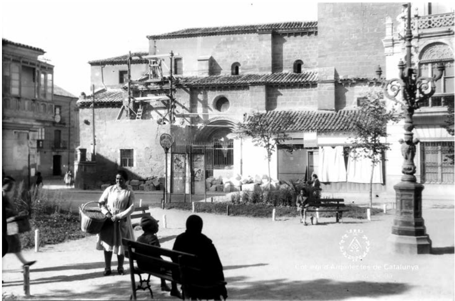
Fig. 8. Demolición del pórtico y sacristía de la Iglesia de Santiago del Burgo, c. 1931-32, Alejandro Ferrant, COAC Demarcació de Lleida .
