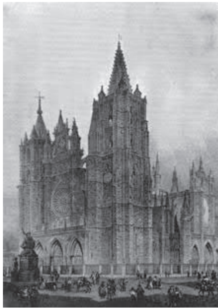
Fig. 1. Vista general de la catedral de León antes de la restauración. Francisco J. Parcerisa. 1855.
